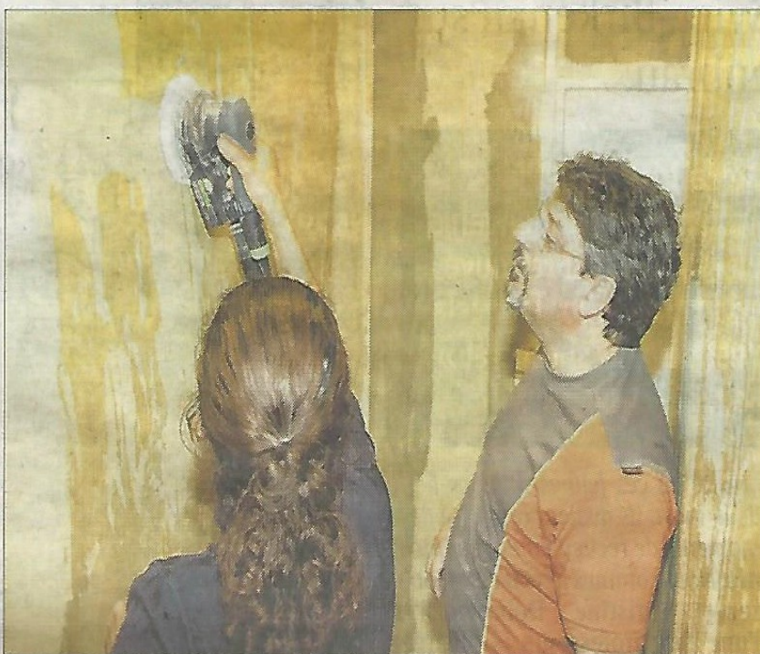
Les travaux sont réalisés avec l'appui d'un conseiller technique.
